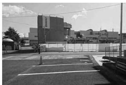
▲旧西公民館解体工事
