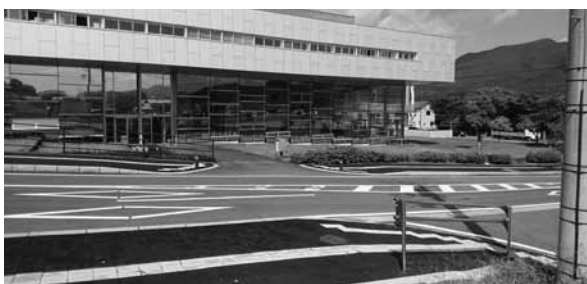
▲横断歩道設置依頼箇所
