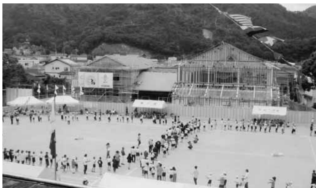
▲有田小学校の改築現場
