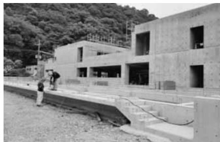
▲建設中の有田小学校校舎 9/4現在
