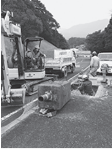
▲街路灯撤去作業の様子
