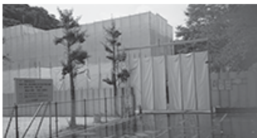
有田小学校解体風景
