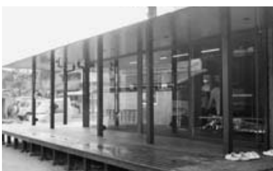
▲古民家を改修して作られたサテライトオフィス
