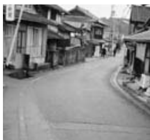
▲殆ど消えかかっている外側線
