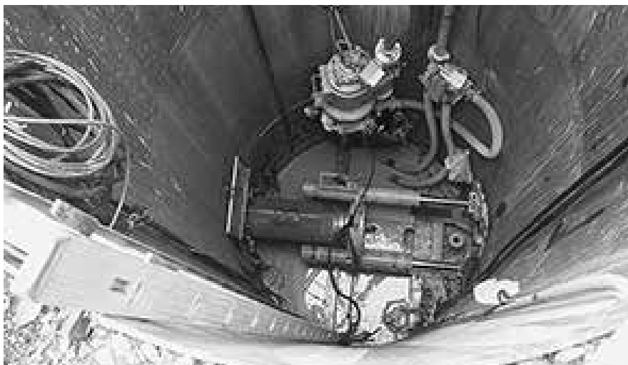
▲公共下水道の推進工事のようす (コブラ工法)
