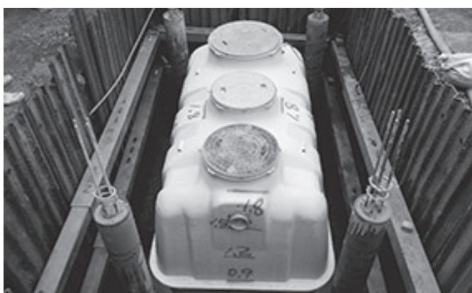
▲浄化槽設置工事の様子
