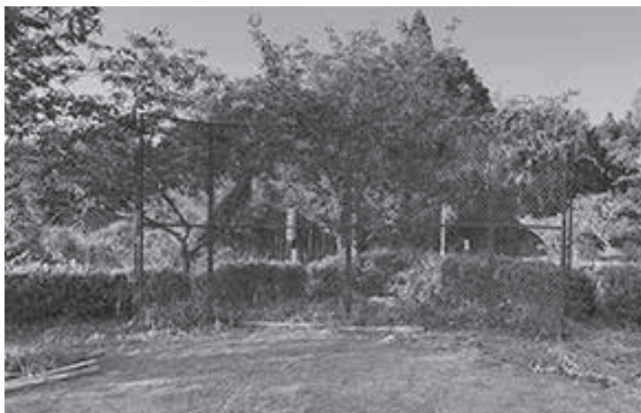
▲桜ヶ丘公園の老朽化したバックネット
