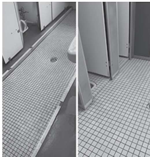
▲曲川小学校トイレの様子
