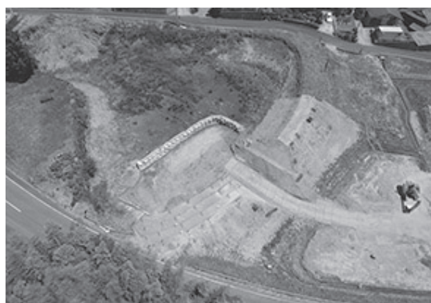
▲ため池改修工事の様子
