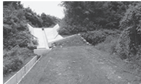
▲未使用溜池防災工事
