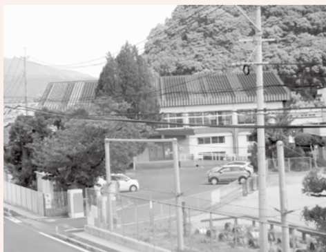
▲大山小学校体育館の屋根の状況
