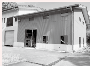
▲最終処分場の管理棟
