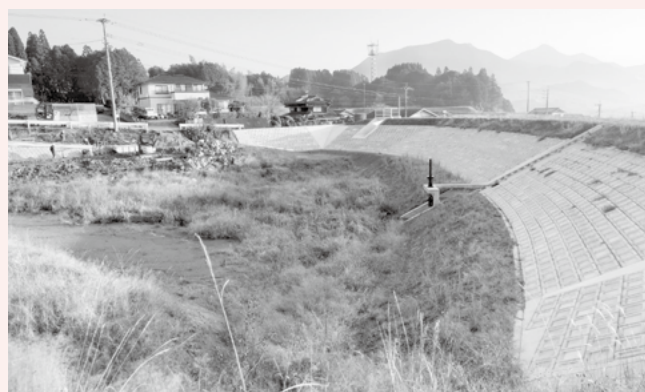
▲県工事で整備中の老朽ため池（立部地区）
