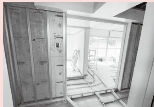
▲定住促進住宅内給排水管工事の様子
