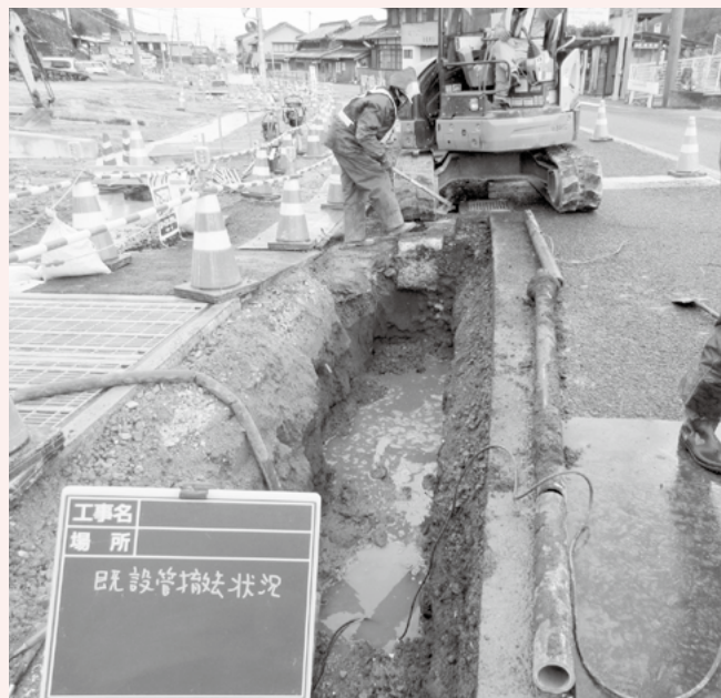
▲今後早急に対応すべき老朽管の布設替え
