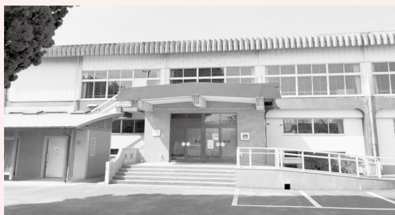
▲大山小学校体育館
