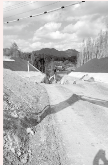
▲開発工事中の南原原宿線
