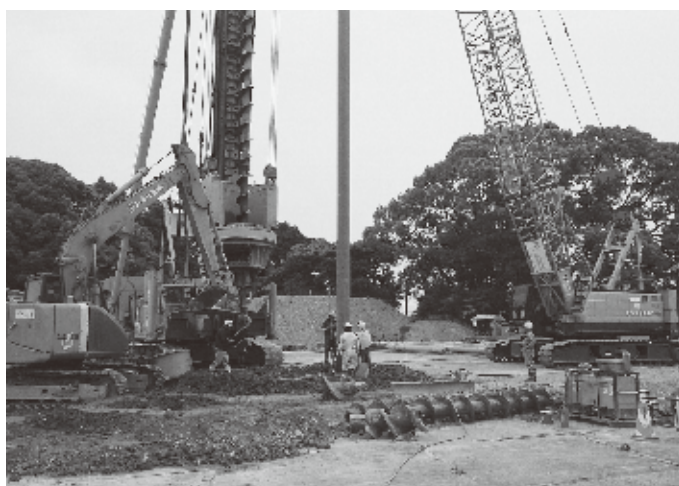
▲有田町リサイクルプラザ基幹的設備改良等工事
