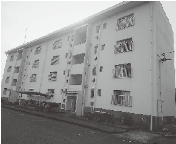
▲東園町営住宅
