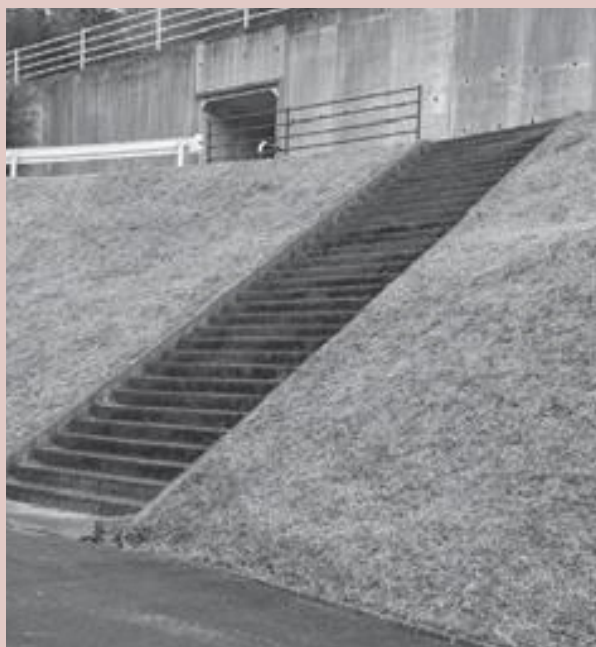
▲階段手すり設置前
