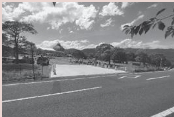
▲正門拡張工事のための仮入口（後に閉鎖予定）
