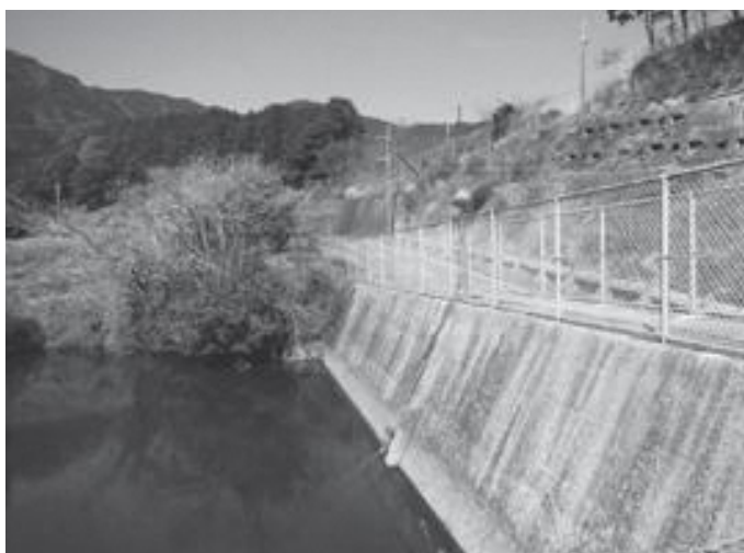
▲ため池監視システム
