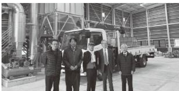
▲有田町リサイクルプラザ 剪定枝・草類処理施設
