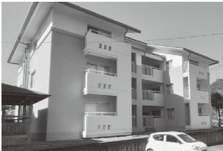
▲泉山町営住宅
