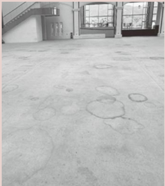
▲張替前の焱の博記念堂コンベンションホール床
