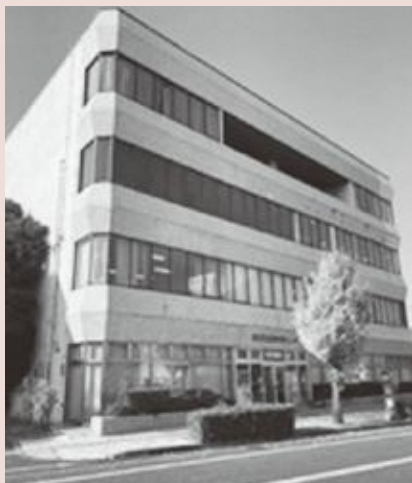
▲生涯学習センター北館
