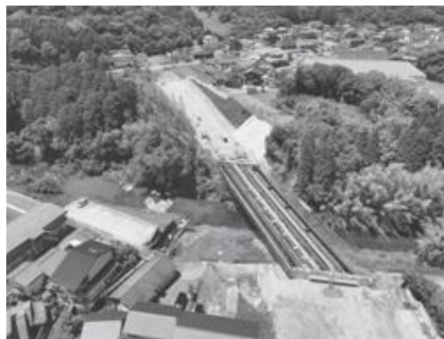
▲南原原宿線の橋梁
