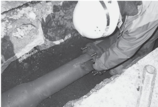
▲水道管布設工事の様子
