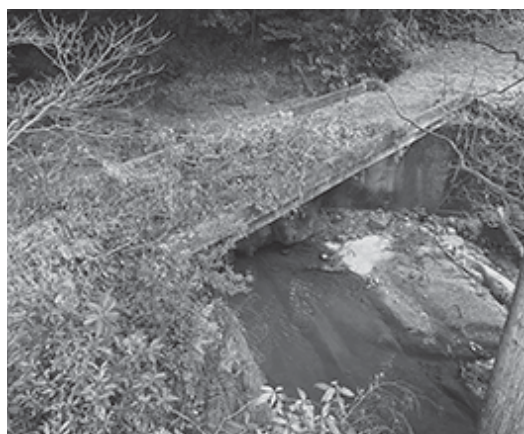
▲撤去が予定されている立木原橋
