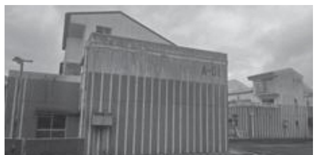
▲中樽町営住宅1・2号棟
