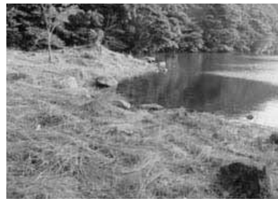
▲土石の堆積で浅くなった龍門ダム
