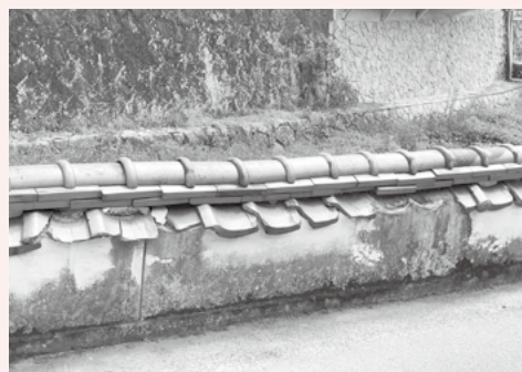
▲白壁風の防護壁
