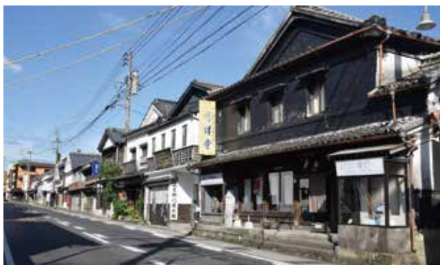
内山地区の町並み②
