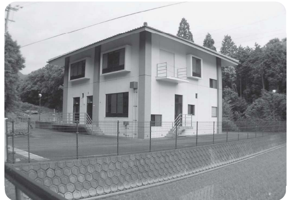
▲農業集落排水処理施設楠木原地区
