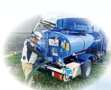
バキュームカーによる 汲み取り作業
