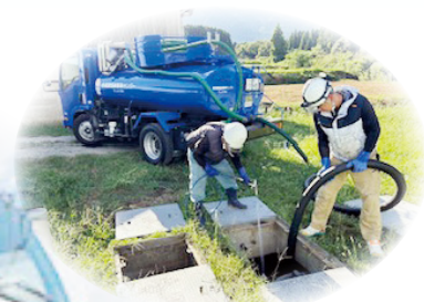
浄化槽の清掃
