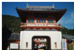
武雄温泉楼門
