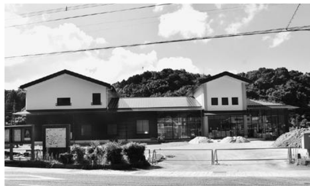
▲建設中の佐賀銀行新店舗建物（東出張所移転先）の外観
