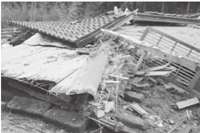
▲倒壊した家屋
