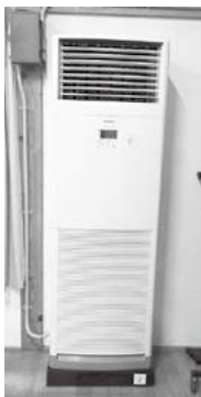
▲整備されたエアコン。
