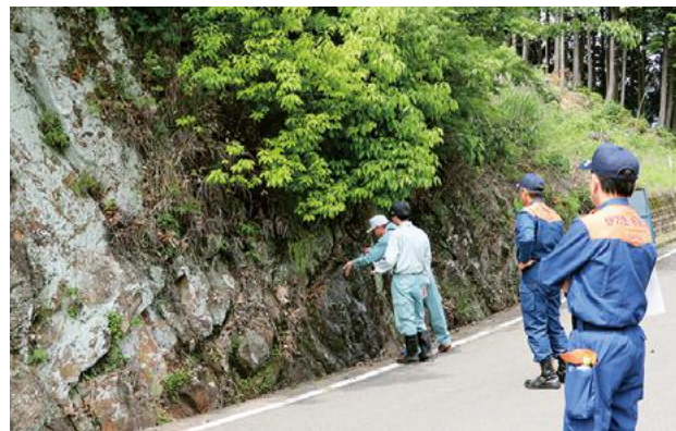
▲楠木原地区にある町道傍の崖の状況確認。出水期を前に、危険箇所を確認しました。
