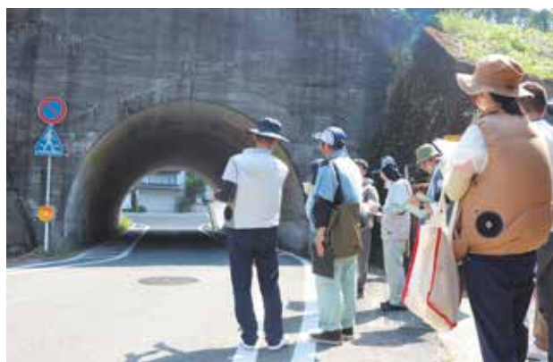
▲県道233号上有田停車場線のトンネルを点検する関係者。幅員が狭く、見通しが悪いことから注意が必要です。
