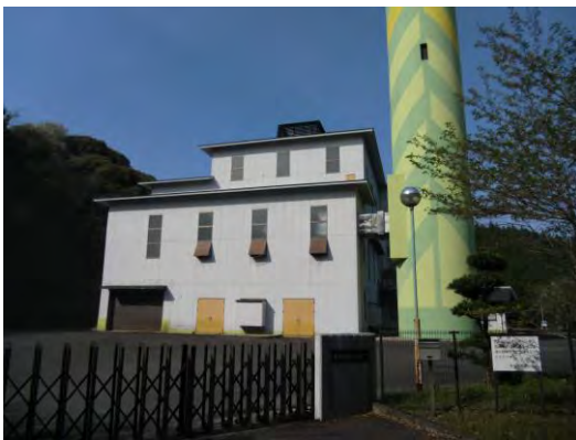
【有田町クリーンセンター】
