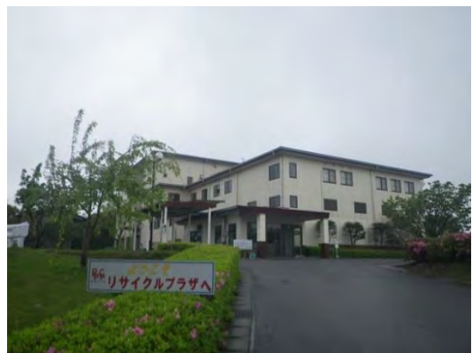
【有田町リサイクルプラザ】
