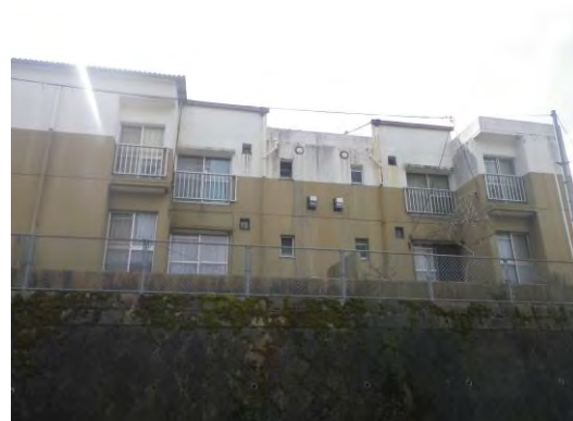
【中樽町営住宅】
