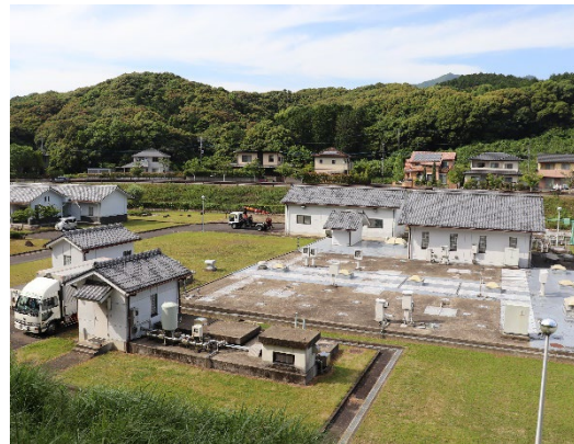
【公共下水道水質浄化センター】
