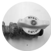
▲図3. 止水栓（レバー、バルブ、キャップの種類あり）
