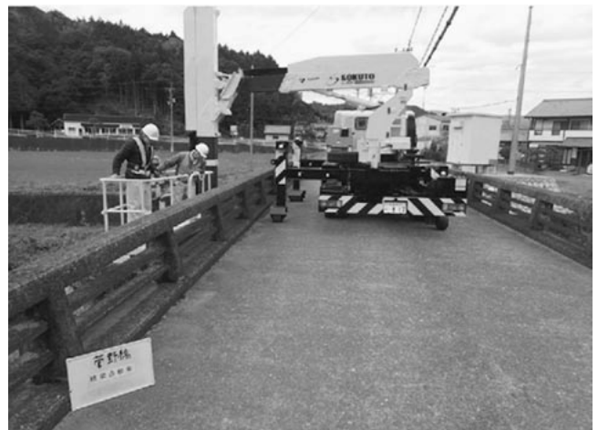
▲橋りょう点検車による点検
