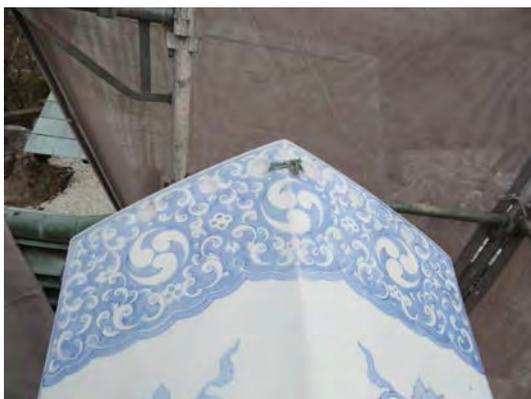
← 「笠木」両端の丸穴開口部の防水処理完了 →
