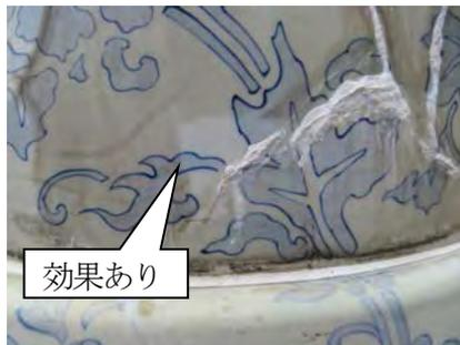
\*鳥居内部からの析出物や大気中の汚れ付着物など状況に応じて臨機応変に工具や薬剤を組み合わせる除去作業を行う必要があると判断する。
