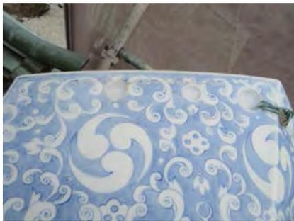
\*「笠木」内部へ雨水が侵入し、鳥居のヒビ割れや劣化に影響を与えている。このため、開口部やヒビ割れ部を塞ぎ劣化を防止する。
