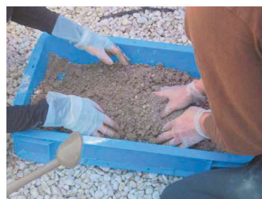
最後に“にがり”を入れ、水を適量加えてよく混練したら完成
