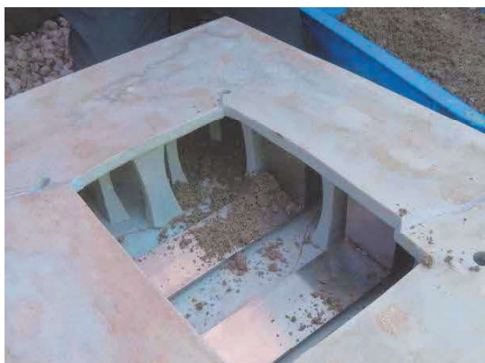
(1)台座内に混合土を充填する
