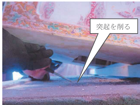
↑ 台座を設置台に仮置きし、水平を確認しながら設置台の突起部を削り調整する ↑
