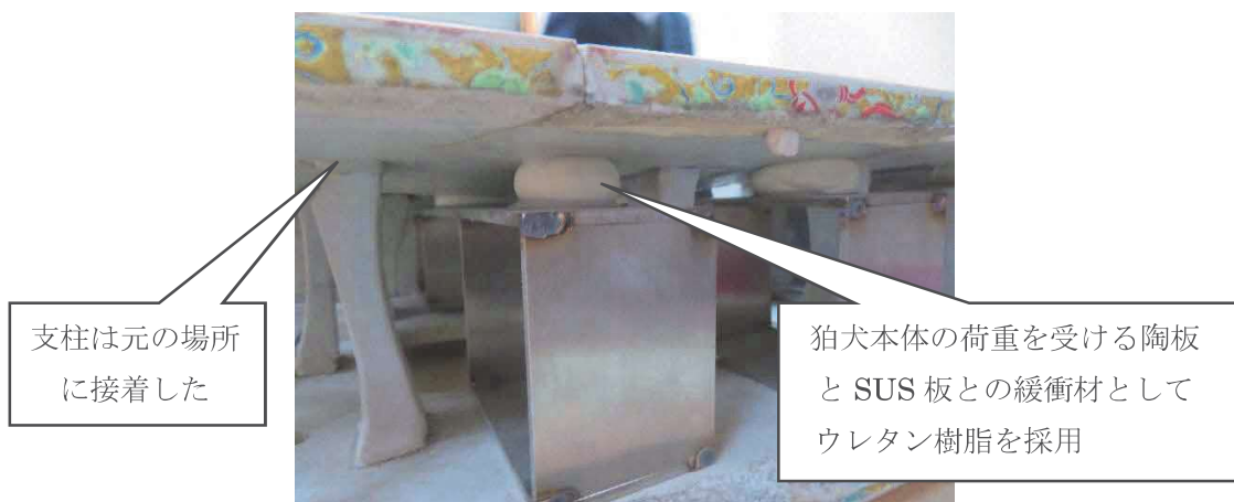
台座内部の SUS 板補強方法
