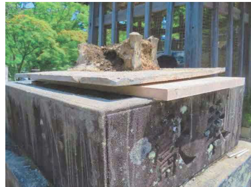
4. 受け板で底板を取り外す
