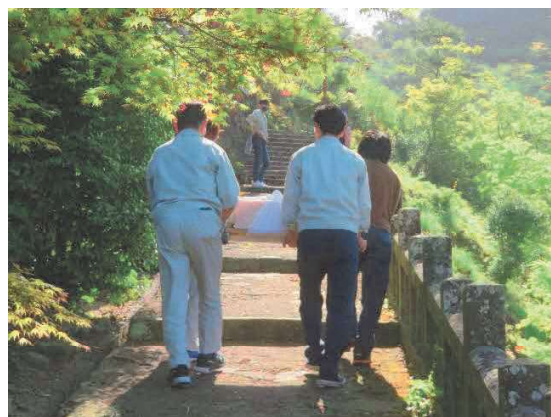
京都で修復された台座を搬入する
