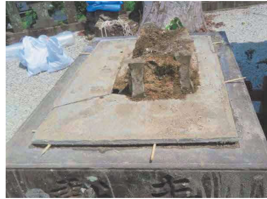
2. 台座と設置台の隙間に割り箸挿入
