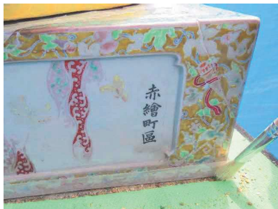
咩形台座と設置台間のシール前処理
