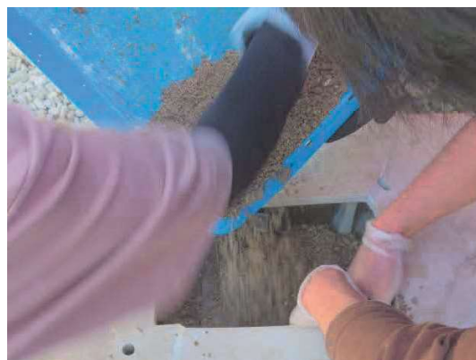
(2)隙間なく充填し突き固める
