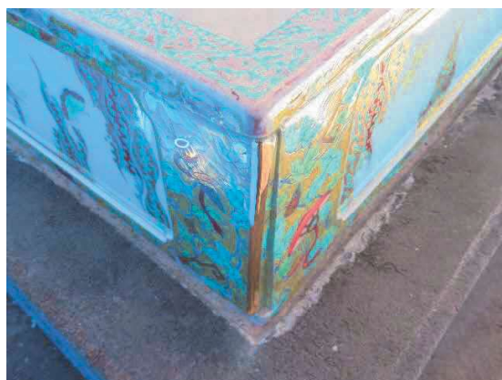
正面右手前の角部
