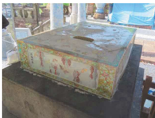
阿形台座据付け完了
