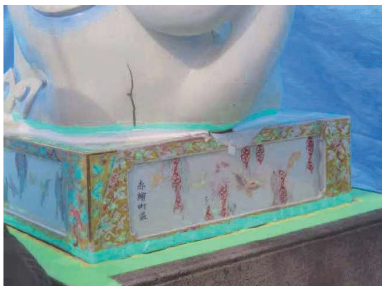
阿形台座と設置台間のシール前処理
