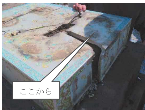
1. 後方右から解体
