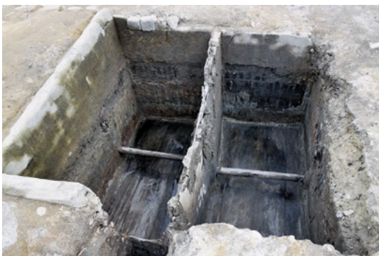
水簸用水槽の構築状況（泉山一丁目遺跡）
