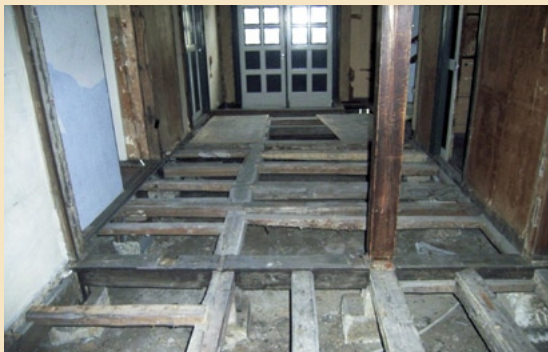
建物内部を一部解体し、痕跡調査を実施
