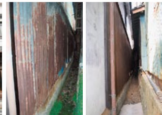
修復前 修復後
