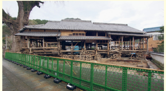
曳家中 敷地内に曳家工法で移転していきます。
