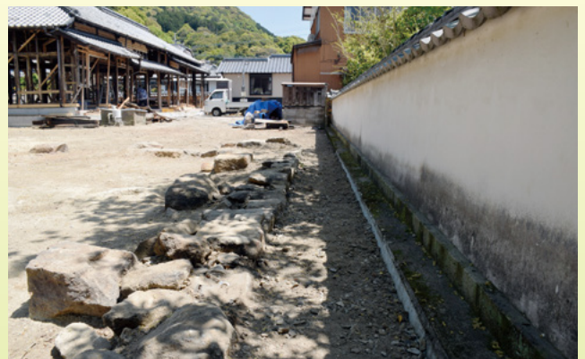
曳家後 柱を支えていた礎石が残っています。
