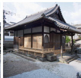
法元寺修理後
