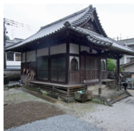
法元寺修理前
