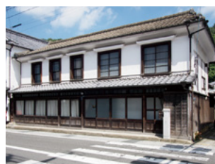
松本家 (修理前)
