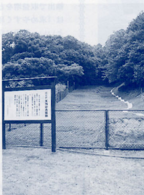
保存工事後の状況
