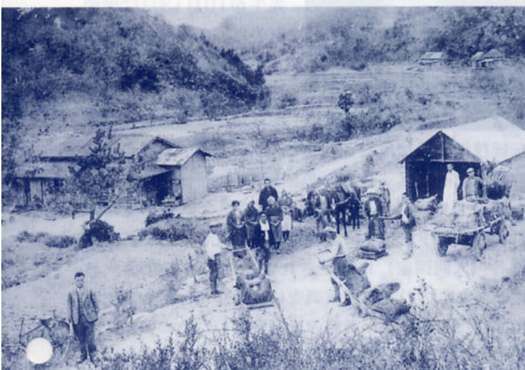
昭和3年から7年にかけて国道33号線（当時）の拡幅工事が行わ れた。幅員2間（3.64メートル）を5間（9.5メートル）に広げ る工事が行われたが、そのころの有田銀行（現在の佐賀銀行有田支 店）前の工事の様子。 〈大樽・手塚信雄さん提供〉
