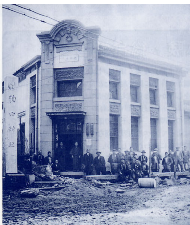
昭和3年から7年にかけて国道33号線（当時）の拡幅工事が行わ れた。幅員2間（3.64メートル）を5間（9.5メートル）に広げ る工事が行われたが、そのころの有田銀行（現在の佐賀銀行有田支 店）前の工事の様子。 〈大樽・手塚信雄さん提供〉
