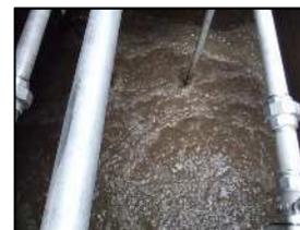
微細気泡散気装置の運転状況
